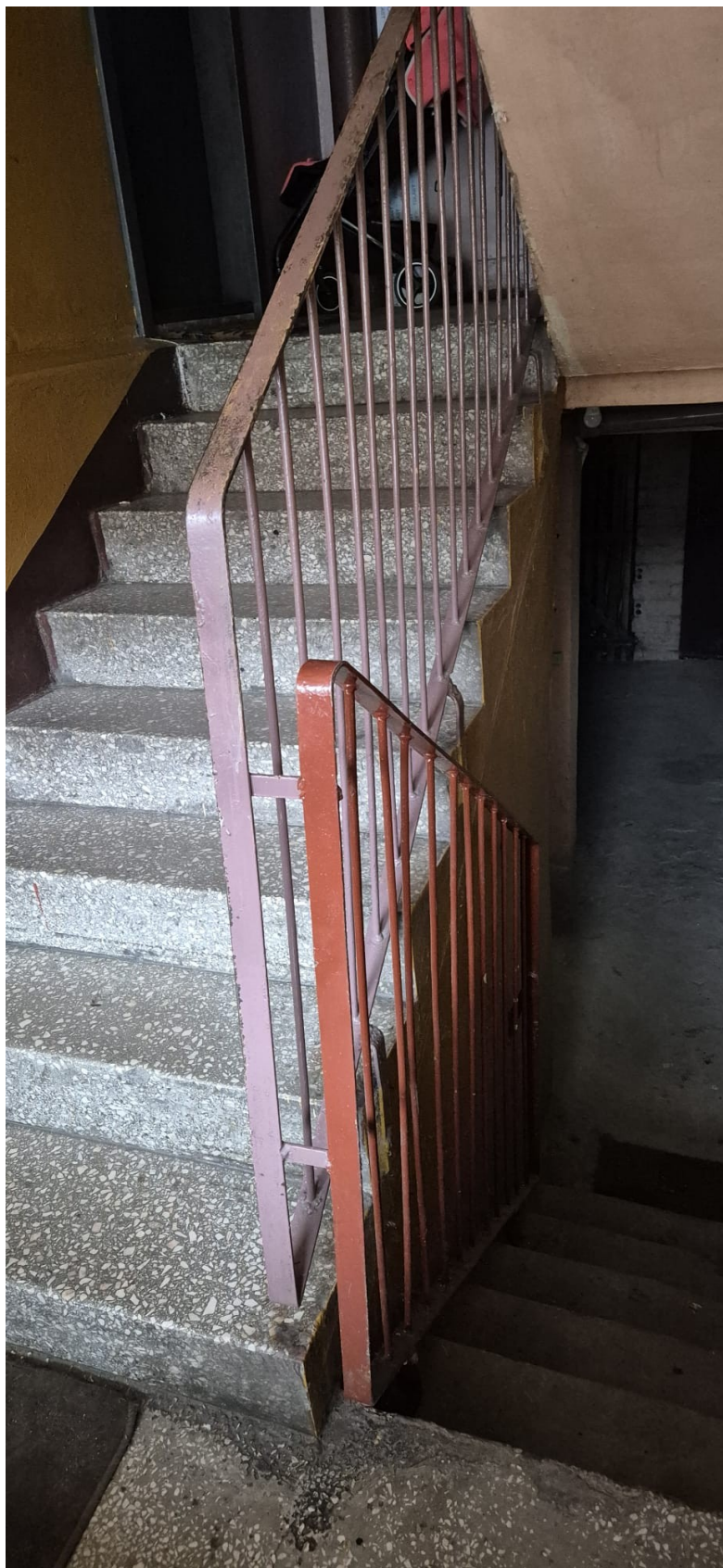
Na klatce schodowej przy zejściu do piwnicy znajduje się poręcz o długości około 170 cm.
